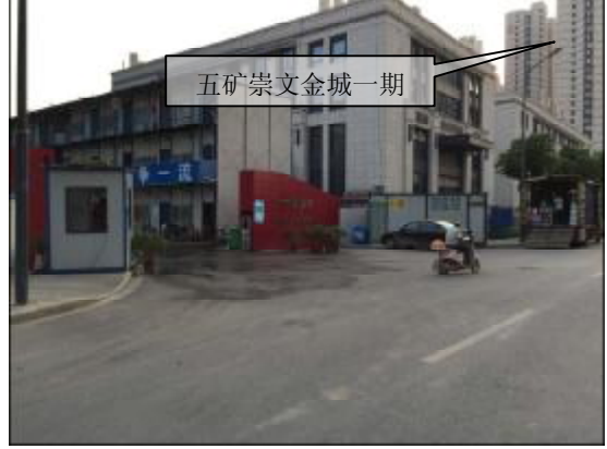
道路起点现状 2
