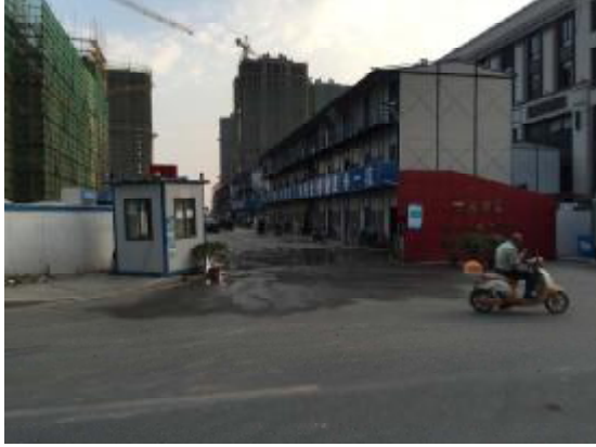
道路起点现状（由北向南）
