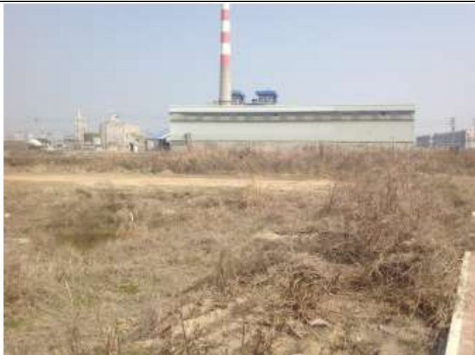
图 3.1-3 东侧厂界现场情况图
