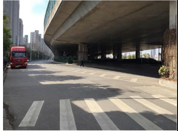
拟建道路北端点向西看，道路为应天大街（含高架），南侧建筑为莱蒙水榭春天
