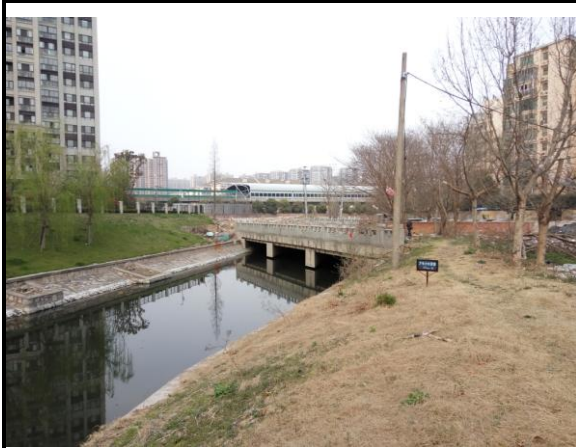
往北看拟建道路穿越的幸福沟河及经过的桥梁，西侧建筑为莱蒙水榭春天小区
