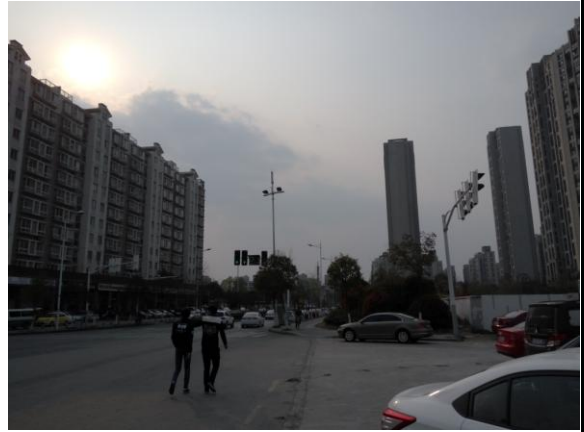
拟建道路南端点围墙外向西看，道路为月安街，道路北侧为莱蒙水榭春天，南侧为翠杉园
