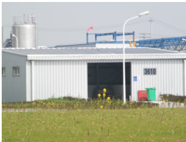
图 3.5-1 现有危险废物储存场所
