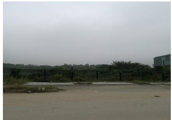
步步高南侧道路终点现状
