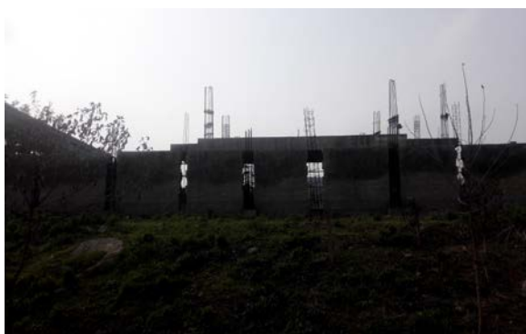
道路拟建地现状空置工地
