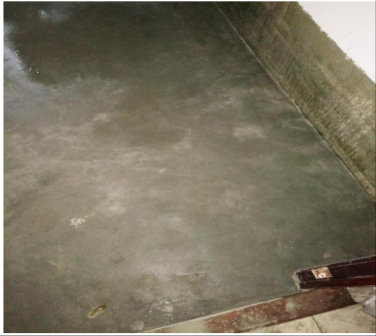
危废暂存间地面防渗涂层
