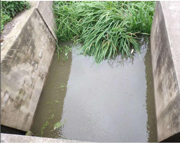
图 1-3 洪东排涝站现状图
