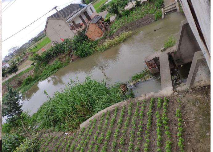
图 1-4 汪家沟闸站现状图
