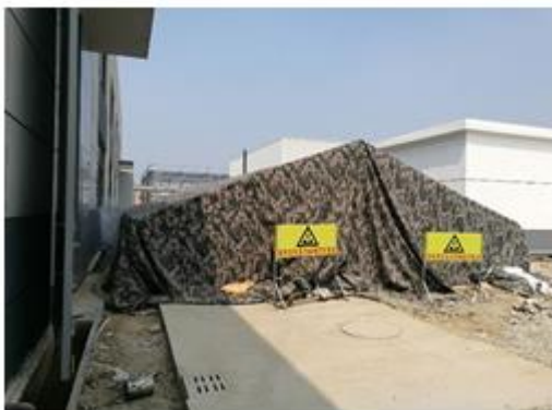
固废填埋区开挖后基坑现状
