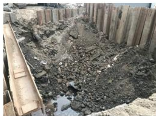
固废填埋区开挖后基坑内部
