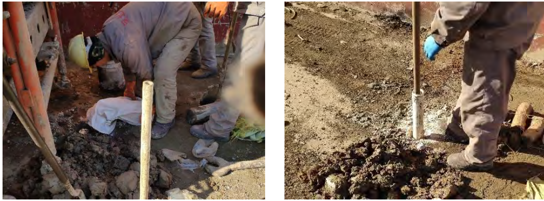
图 6.4-4 场地钻机建井现场
