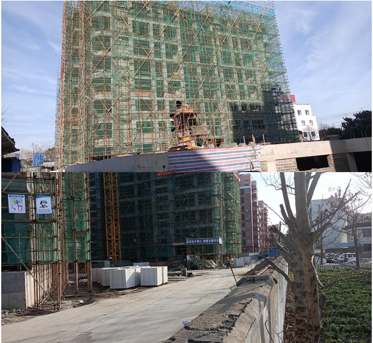
图 2.3-1 地块内现状照片
