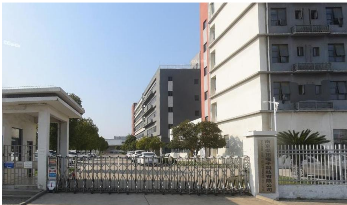
图 2.2-12 南京奥拓电子科技有限公司现场踏勘照片
