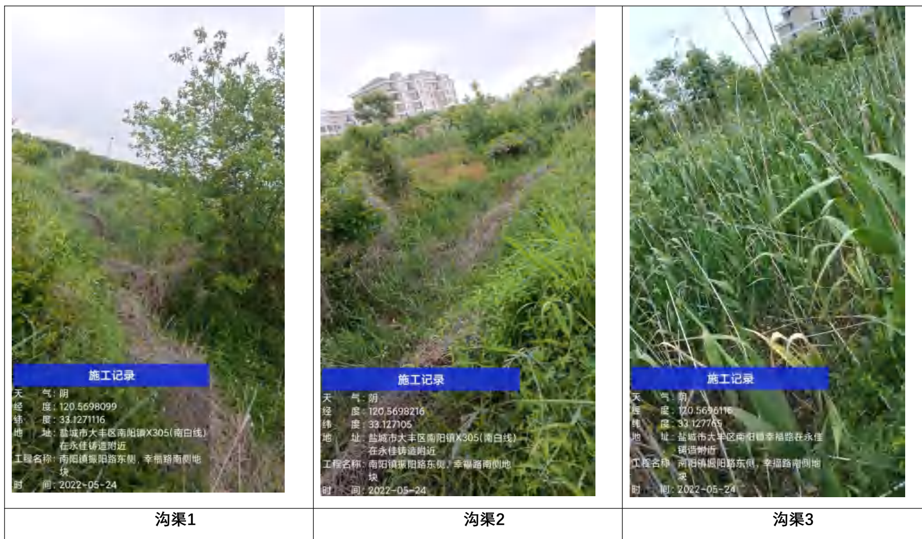
图2.3-3 地块内水渠现状
